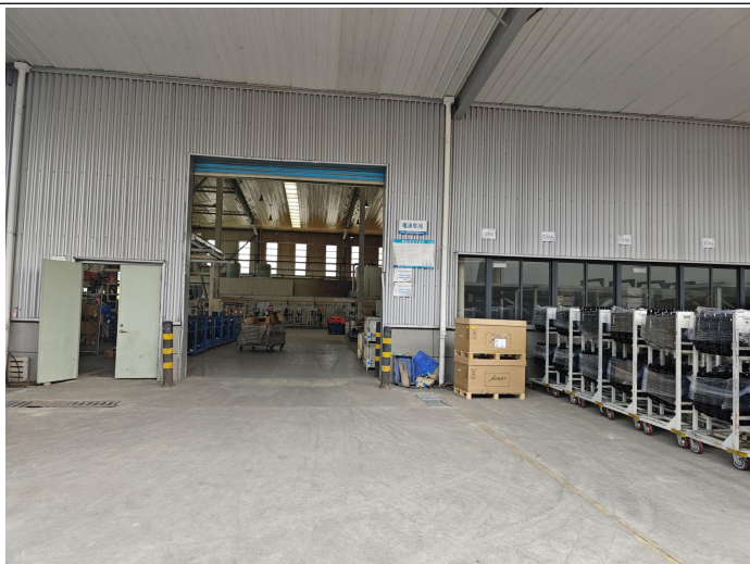
项目北侧为福建爱立德汽车部件有限公司电泳车间
